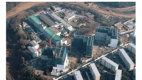
建設工事中の「松戸ニッセイエデンの園」
