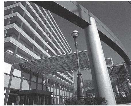
「松戸ニッセイエデンの園」本館玄関付近
