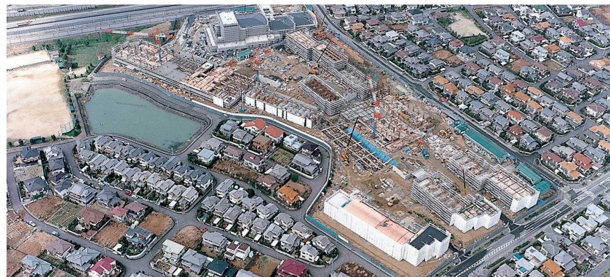
工事風景(1991年3月)
