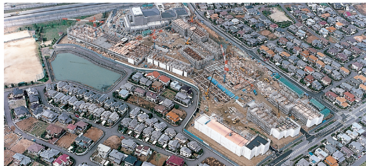
工事風景(1991年3月)
